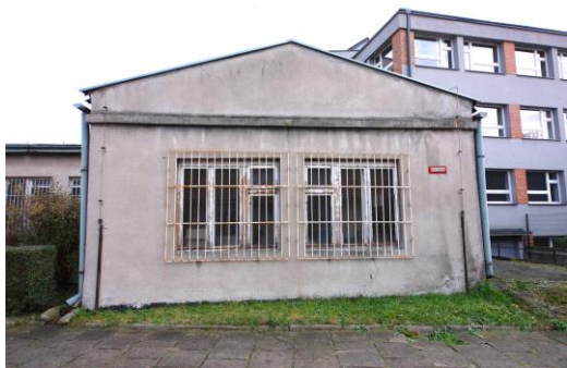
Fot. 1 Budynek 10-14 przed modernizacją.
